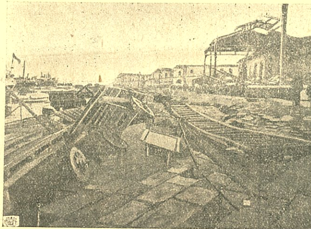
Estação dos Caminhos de Ferro de Messina, mostra as fendas na Rua
